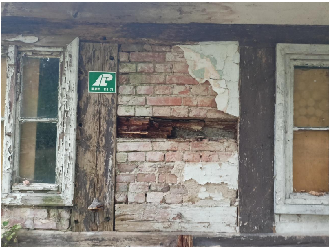
WIDOK ELEMENTÓW DREWNIANYCH ŚCIAN SZKIELETOWYCH.
